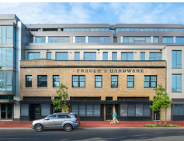
1101 PENNSYLVANIA AVE, SE
